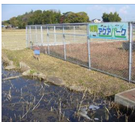
▲切間川浄化施設（安城市） 浄化した水が流出するところにはアクアパークとして、ピオートの整備もされているよ。
