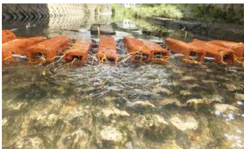
設置、完了です
